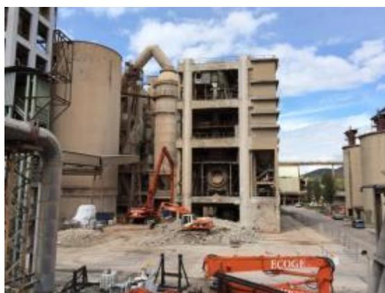
*Fase di demolizione della torre di preriscaldamento mediante sezionamento in conci delle sue parti per mezzo del taglio diamantato a filo.*
