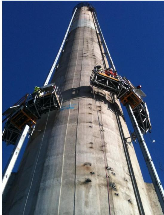
*Ponteggi mobili previsti nel piano per la demolizione in quota mediante l'impiego di attrezzatura oleodinamica manuale.*
