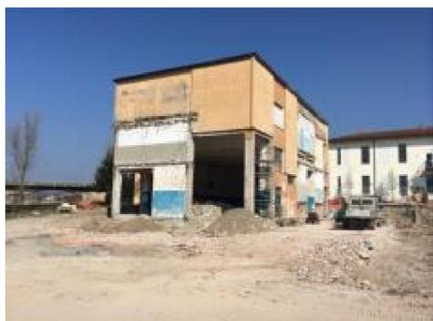
*In particolare il corpo palestra, con la messa in luce della struttura portante in cls armato, in prospettiva del suo consolidamento statico.*
