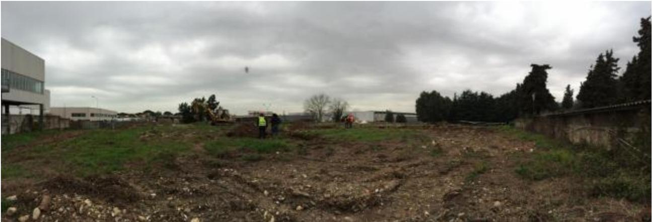
All'interno del perimetro del comprensorio industriale EATON di Massa, la proprietà ha deciso di rimuovere un deposito di rifiuti inerti (terreni di risulta e detriti di origine edile), che si sono accumulati nel tempo in un'area periferica; tale cumulo di dimensioni 65x45x2,5 m è stato caratterizzato dalla Golder Associates S.p.A. ed in successione in sede di omologa del rifiuto per il suo smaltimento dalla scrivente.
