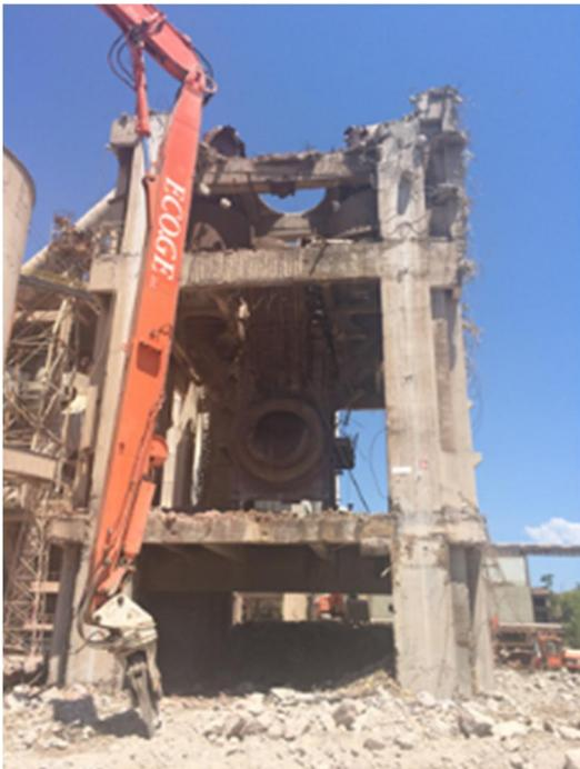
*Parte residuale, in demolizione finale, della torre principale della linea L 1200, sezione "preriscaldamento"*
