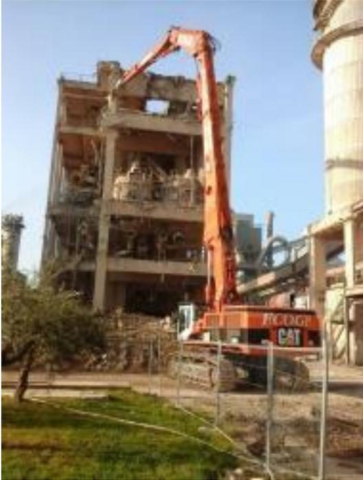
*Progressione della demolizione con impiego di macchina speciale dotata di braccio extra long e pinza frantumatrice.*
