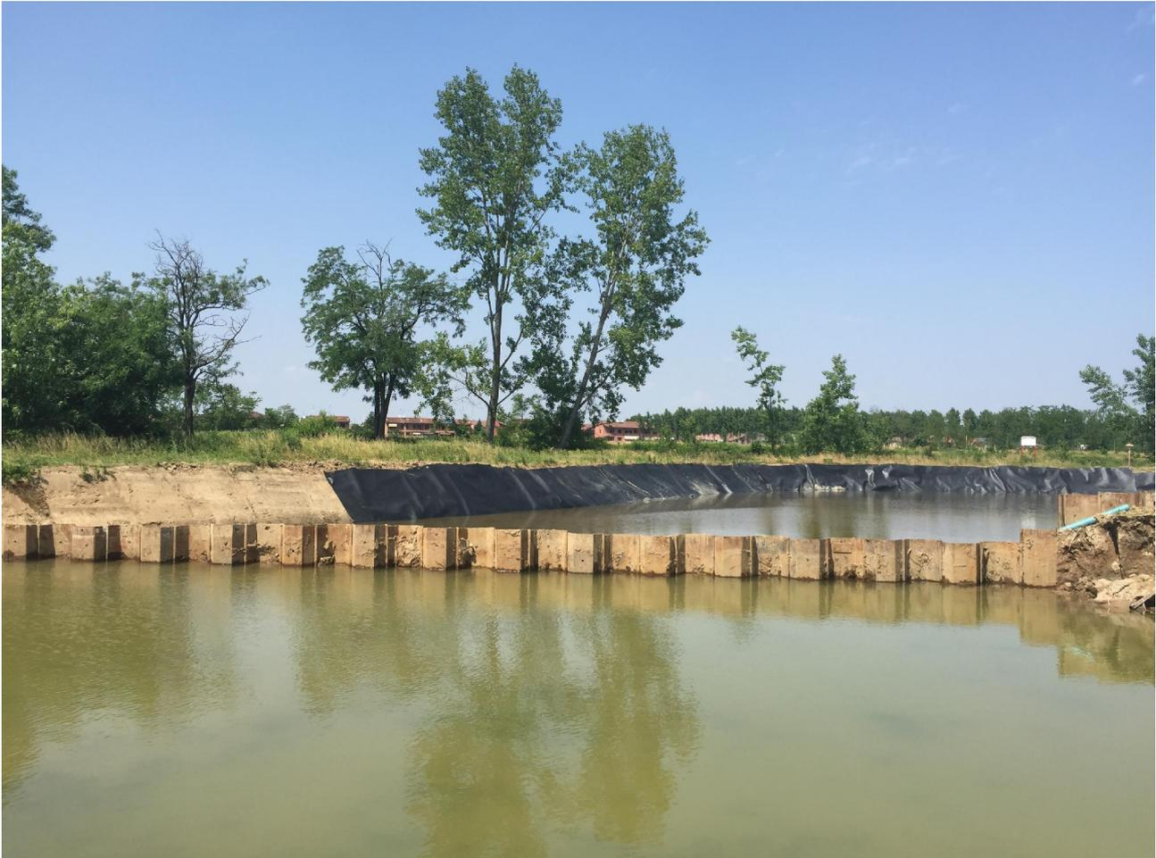
Vista dei Lott 2 (in primo piano) e del 1 (in secondo piano), con rimozione dei terreni non conformi alla CSC del sito fino a 20 cm sotto il livello delle acque di falda, che verranno trattate con ossidanti prima del rinterro (Peroxim).
